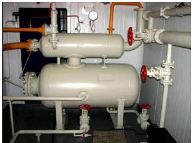
В сепарационной емкости происходит отделение газа от жидкости. Продукция выбранной скважины сначала попадает в гидроциклонный сепаратор, где газ отделяется от нефти. Отделенный газ проходит через датчик расхода газа и направляется в общий коллектор, а нефть скапливается в нижней емкости сепаратора.
